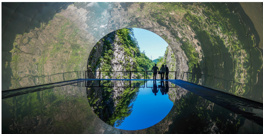
清津峡溪谷トンネルのパノラマステーション。床一面は池のように溪谷から湧き出た沢水を張り、水鏡の風景を演出している。トンネルの壁にはステンレスの板を張っており、半円の外の風
